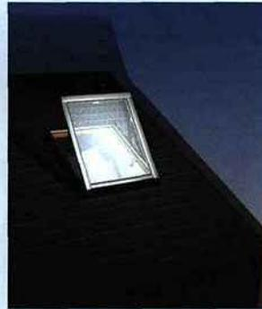
On ne le rappellera pas assez : en cas d'incendie, se sont les fumées qui sont dangereuses pour les occupants et les pompiers. D'où l'importance d'avoir une trappe de désenfumage qui s'ouvre automatiquement en cas de détection de fumées. Souchier, fabricant français de solutions de
